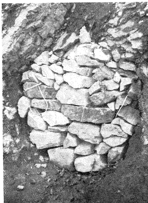
3 埋戻を終つた坑道口、白線は導爆線、坑内の湧出水は逐次底部より流出する。
