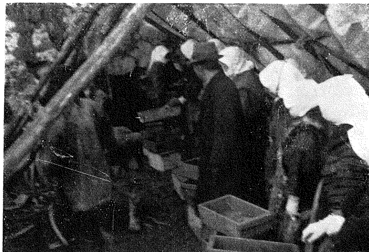
2 前方の坑道口へ埋戻土砂を手送りしてゐる状況。
