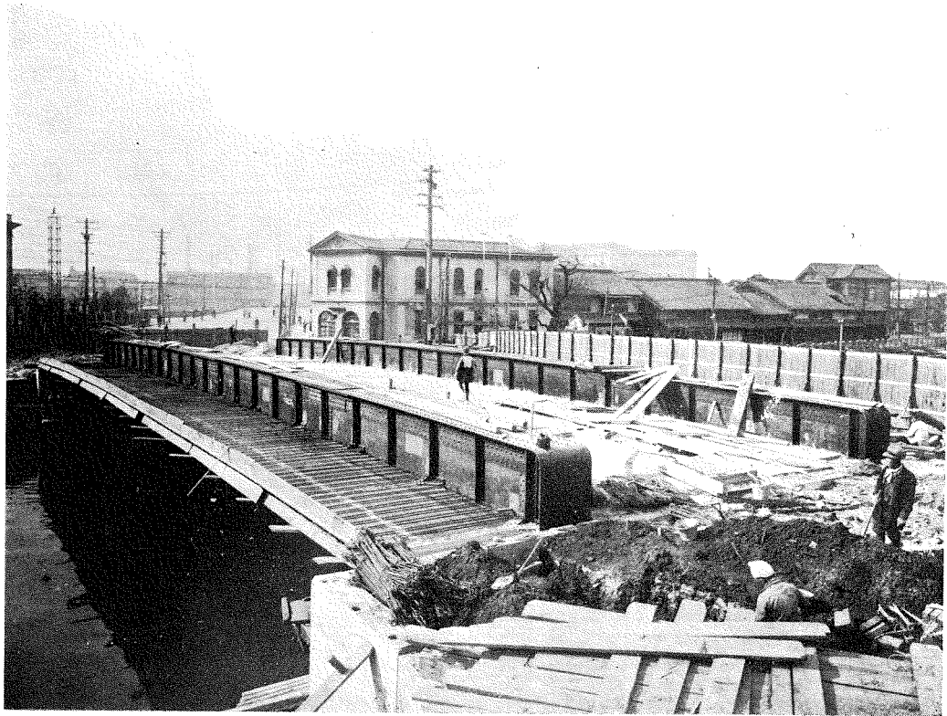
(1) 主桁の架設を終り床版コンクリート施工中の噺喉場橋。
