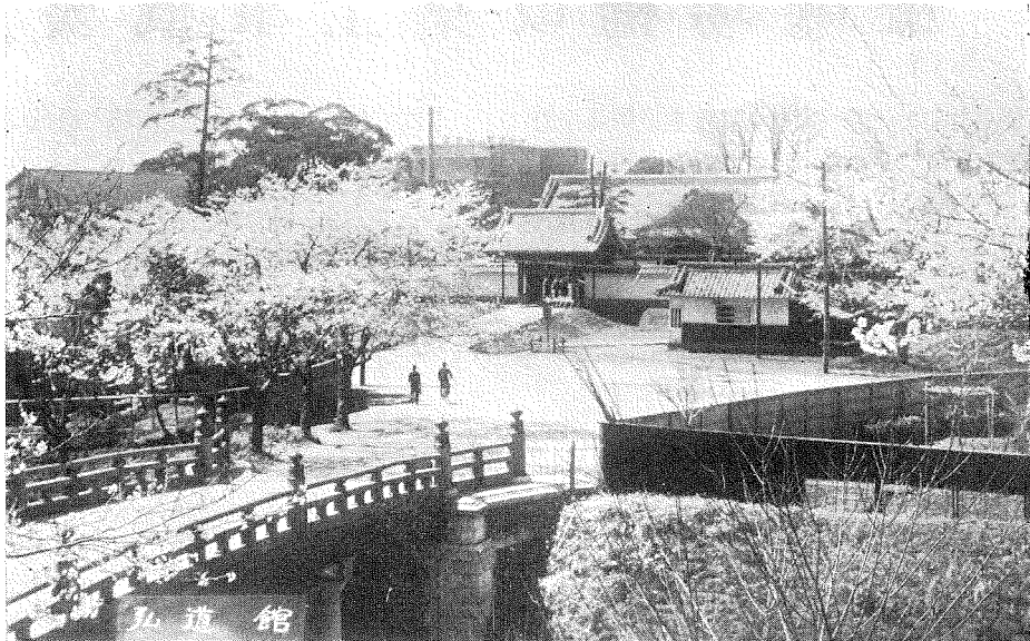
(3) 大 正 四 年 に 架 換 ら れ た 舊 橋 ]
