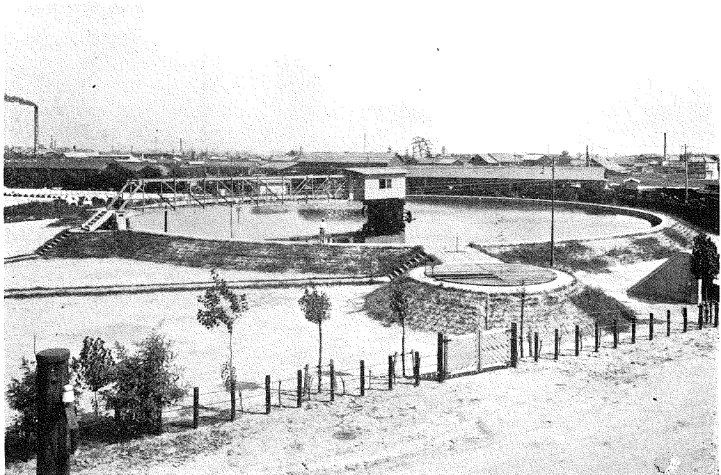
(5) 露橋下水簡易處理場沈澱池。
