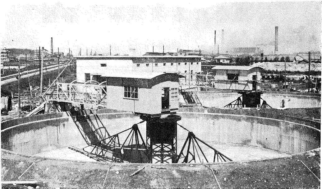
(9) 沈澱池の汚泥聚集機取付状況。
