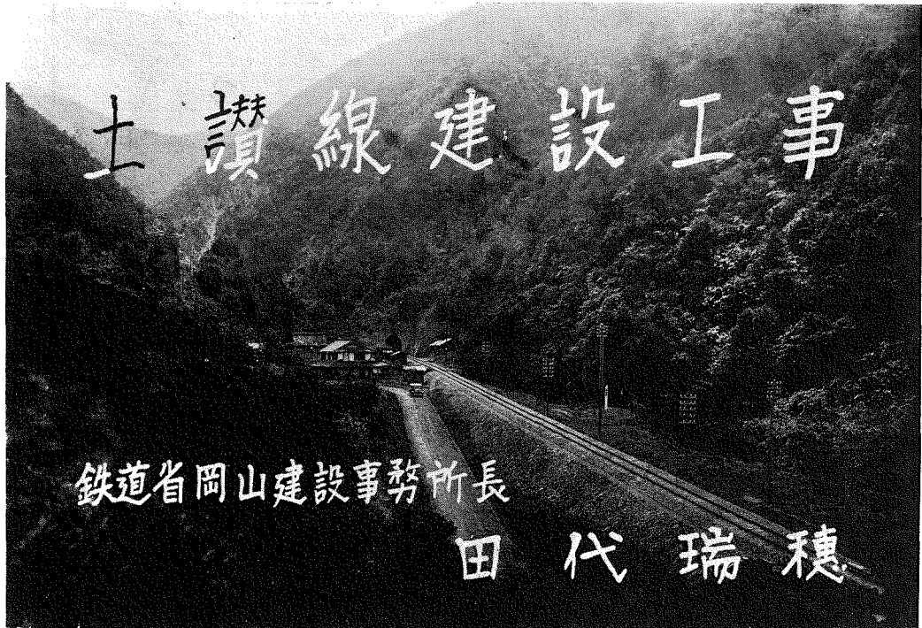
(1) 猪ノ鼻隧道南口坑口附近の線路。
