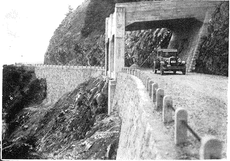
(11) 竣功せる親不知洞門、歌外波村歌地内大雪崩の箇所。
