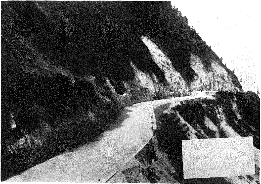
(10) 竣功せる道路の一部、歌外波村歌地内、海岸より約31米高に於ける山腹切取上。
