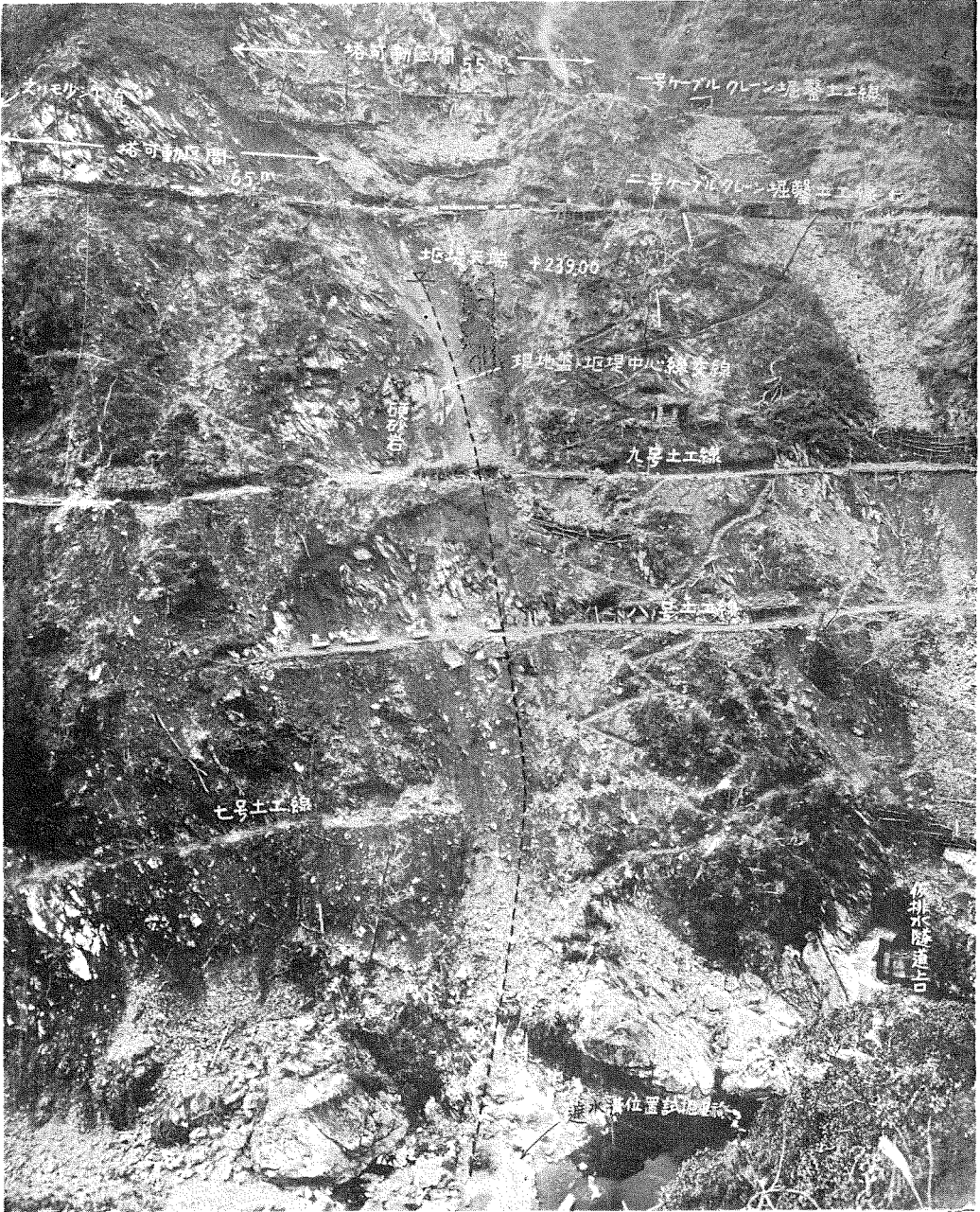
(第3圖 塚原堰堤工事右岸を望む、昭和10年11月22日)
