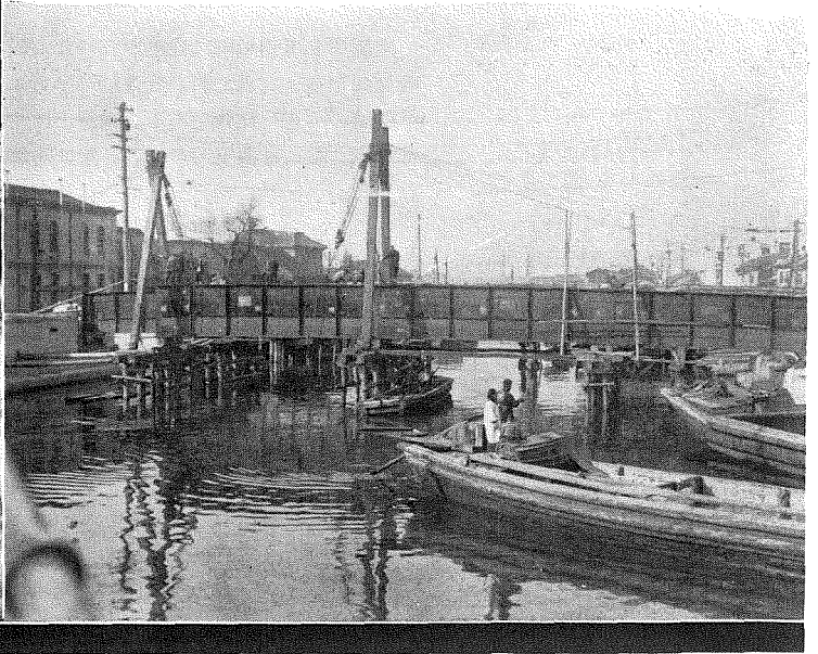
(5) 大阪市難喉場 橋主桁架設状況。
