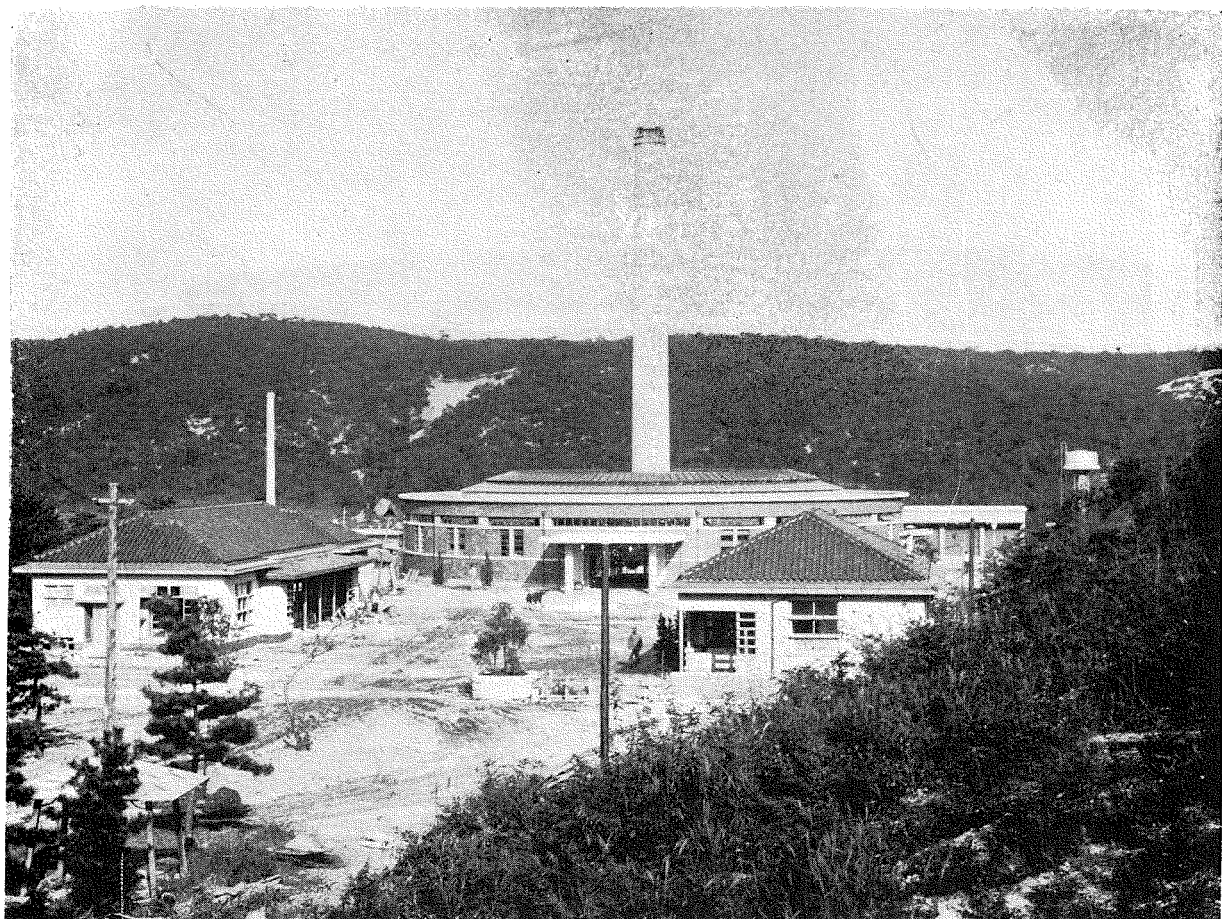
名古屋市営八事火葬場全景。
