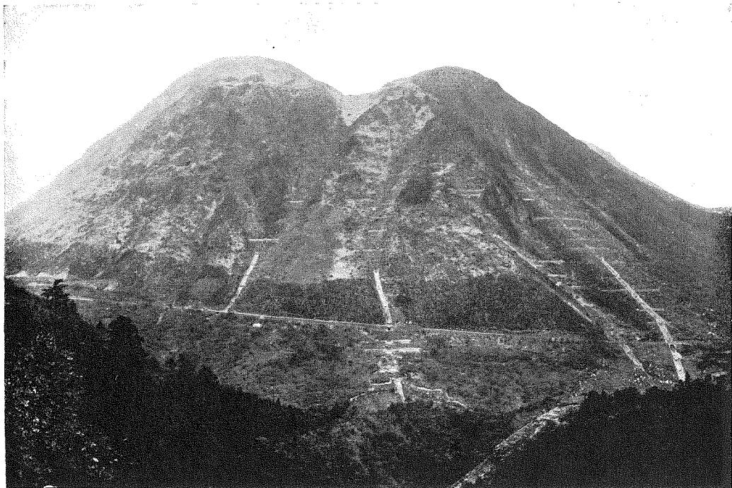
(1) 二子山腹砂防工事、早川支川須雲川流域、神奈川縣箱根湯本町畠宿（箱根舊街道）に施工せるもの、主たる工事は山腹石垣工、張石水路工、谷止工にして施工面積199,680m<sup>2</sup>、工費143,778圓、工期昭和5年度より10年3月まで、寫眞の横一線が箱根舊街道にしてその上右より第2、第3、第4、第5、山腹工、道路の下右より第1、第6山腹工なり。
