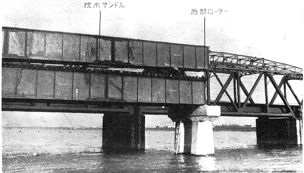
(寫眞3) 桁の前方より約 \frac{1}{3} のところに枕木サドルを組み、桁後部を操重車にて吊り下げ、前部トローリーを抜き取り、桁の前端を後部ローラーへ、後端を操重車のツメに乗せて前進する。 (寫眞4) 重心(寫眞中Gとある個所が手延機を加へた重量の重心)が後部ローラーより約1米出た時控ワイヤーを緩めて手延機の先端を前部ローラーに着くまで傾斜させる處。後部ローラーにかかる荷重は約70噸、送込ワイヤーに来る荷重は8噸。
