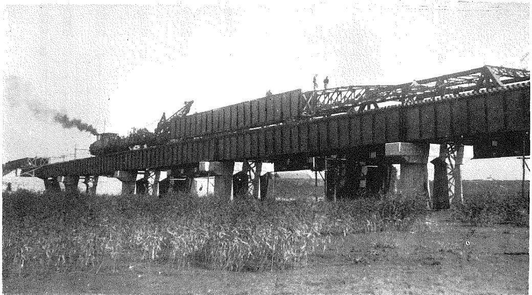
第 2 圖 ↑ (寫真 1) 桁に手延機を取付け機關車にて架設現場に運搬しつゝある狀況。
