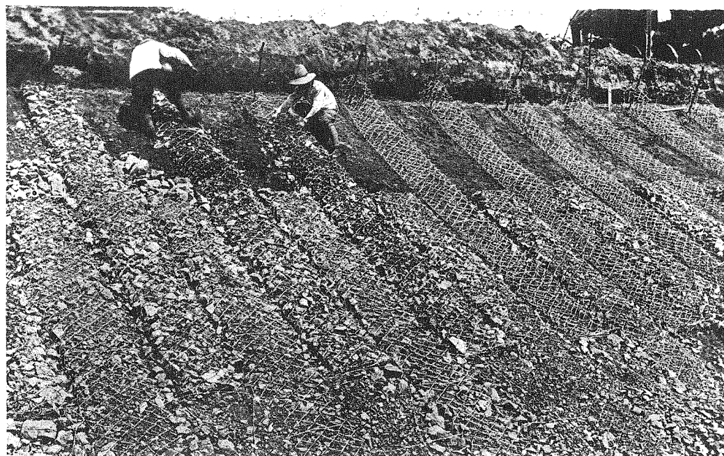
(5) 堤防法崩壊個所の復舊作業實況。
