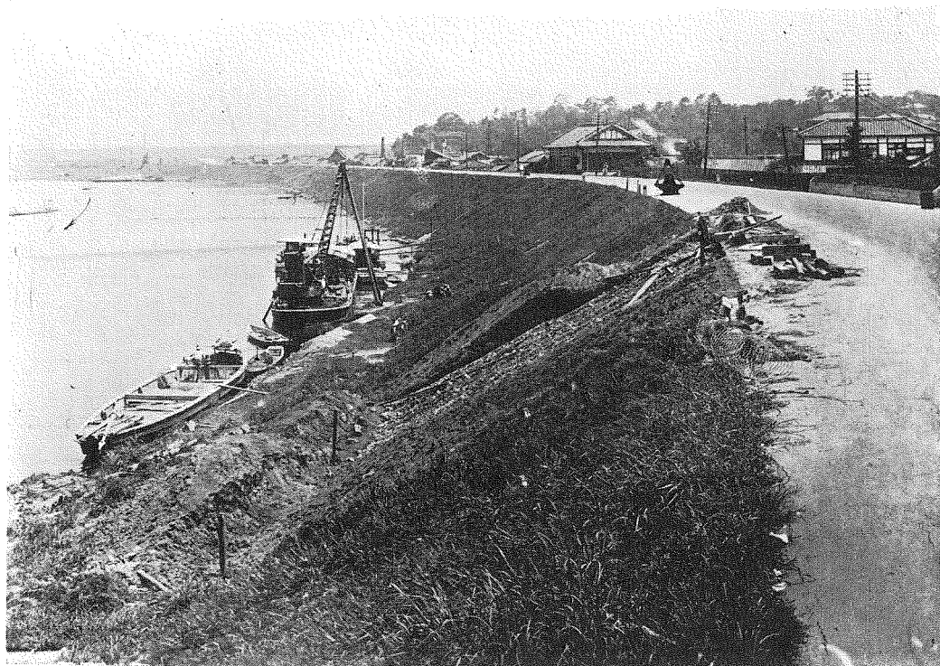
(4) 枚方町地先堤防表法崩壊箇所の復舊工事。
