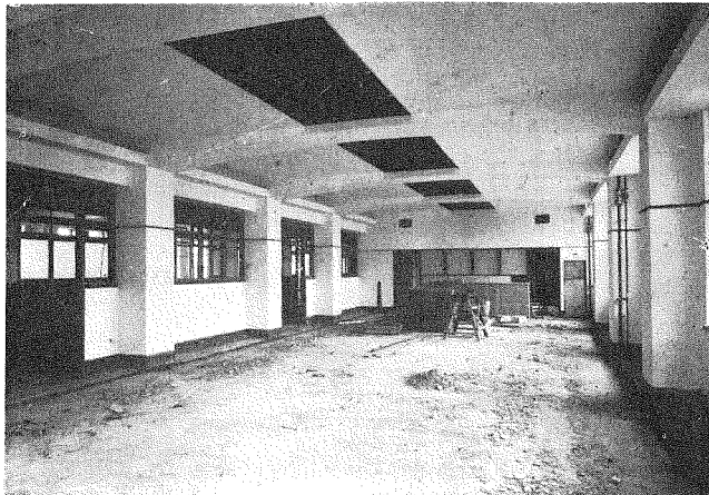
(9) 竣功迫る大阪市水道廳舎(上) (10) 二階事務室の一部(中) (11) 二階食堂の一部(下)
