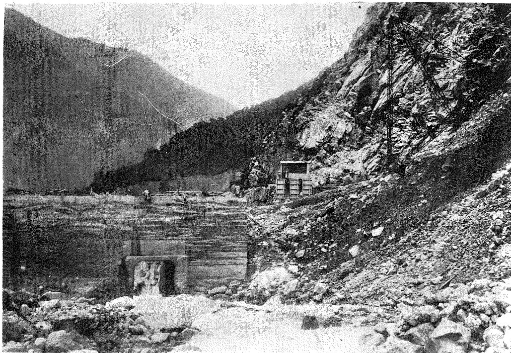
(3) 白岩堰堤工事・昭和9年7月の出水にて堰堤右岸岩盤上の土石大崩壊を來し第3隧道の見張所2棟、材料小屋1棟を埋没した。寫眞は出水後水を以て土砂除却の狀況。
