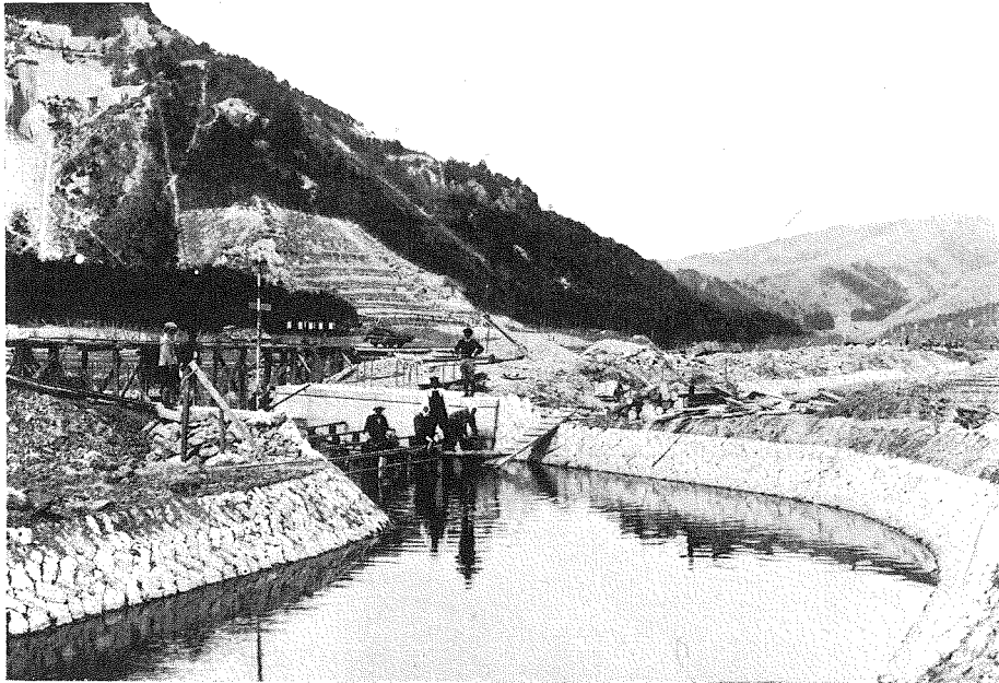
(2) 中川村地内、置賜国道改良第二區第一橋梁及同所附近朝日川の護岸。
