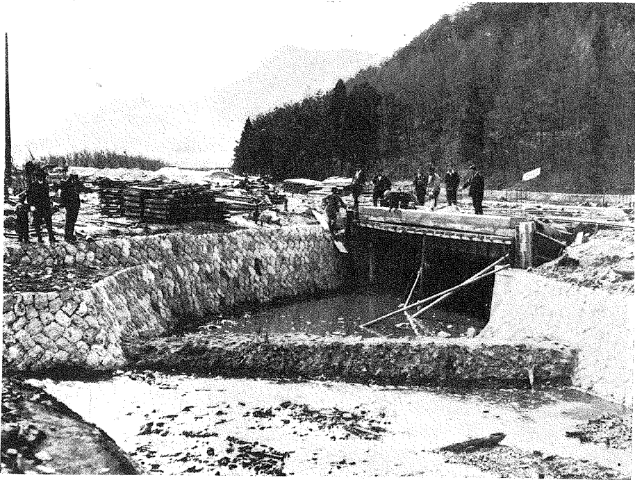
(3) 同上地内、置賜国道改良第二橋梁及朝日川の附替水路、撮影は何れも本年三月三十一日である。
