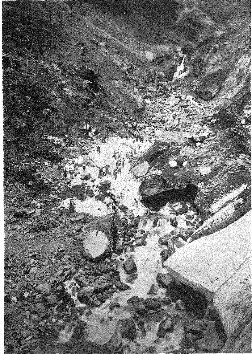
(1) 柳谷第15號砂防堰堤施工箇所上流、石材採取場に於ける積雪除去の状況、六月中旬の撮影である。
