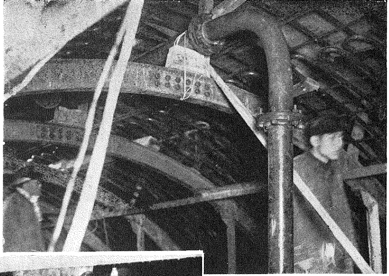
(写真・9) 壓力隧道コンクリート 工事に使用のコンク リート・ブレッサー。
