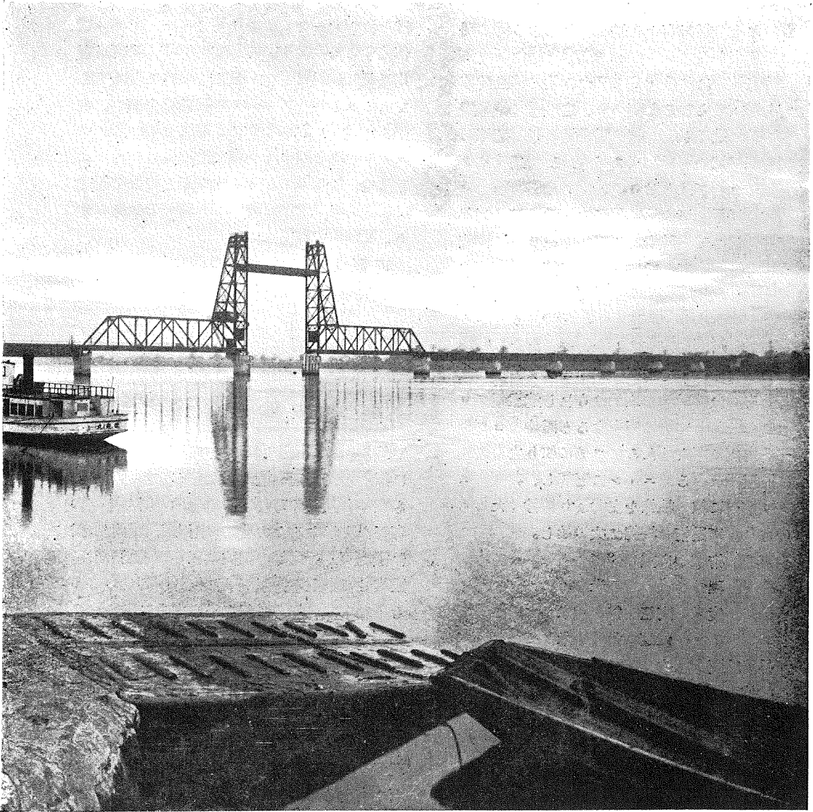
(2) 筑 後 川 可 動 橋。
