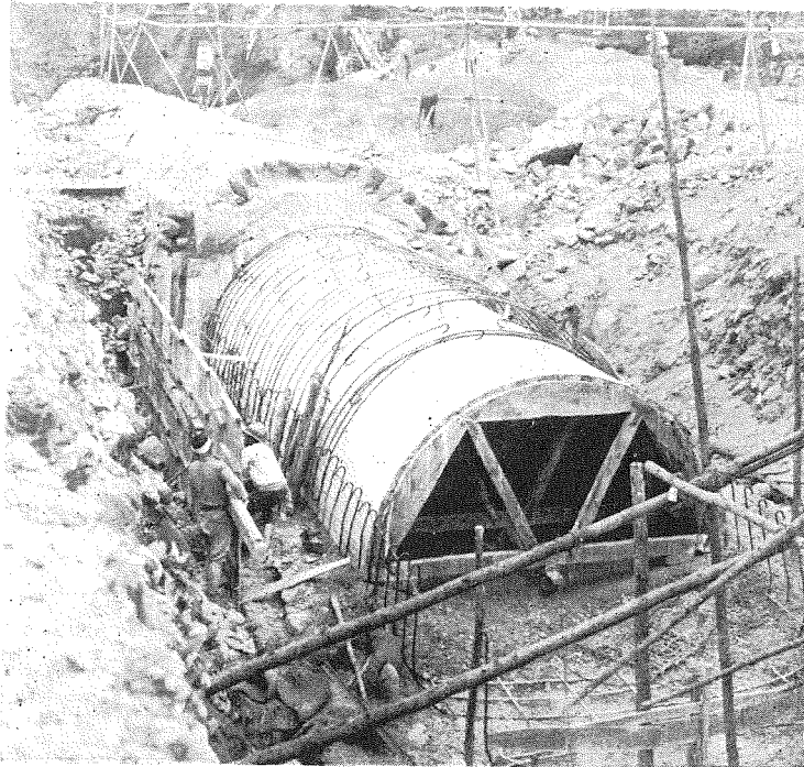
寫眞5・サイフォン巻立施行、鐵筋コンクリート1尺の上に尙2尺5寸の練石積を以て巻立つ。幅12尺高7尺の暗渠である。
