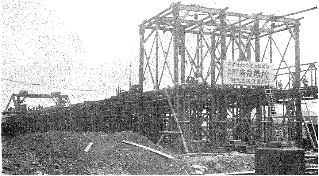
(4) 跨線橋鋼桁架設足場及捲揚装置。
