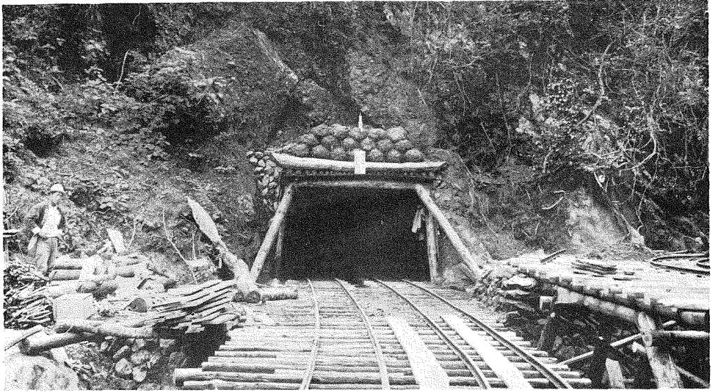
(10・第4號隧道上口横澤横坑)
