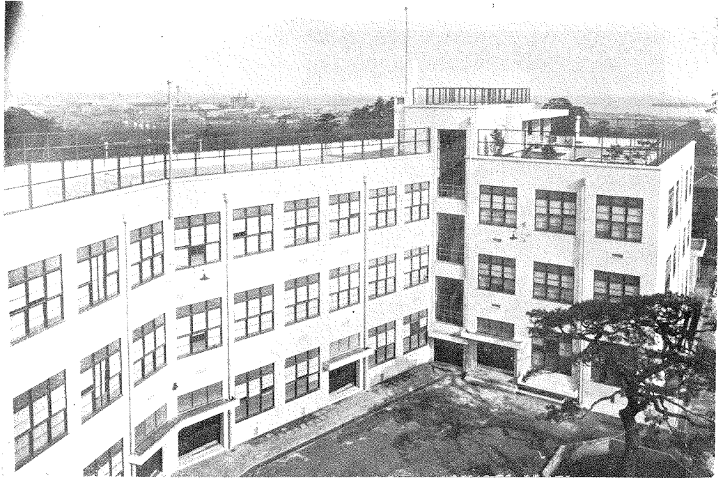
(6) 中央部屋上より見たる校舎の一部。
