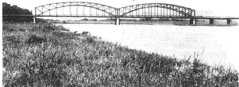
(4) 渡良瀬大橋 繫拱部。
