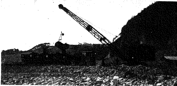
寫眞 105 ドラグライン の活動 10Ton 瓦斯倫車と 6 Ton 積ウエス マン型運搬車
