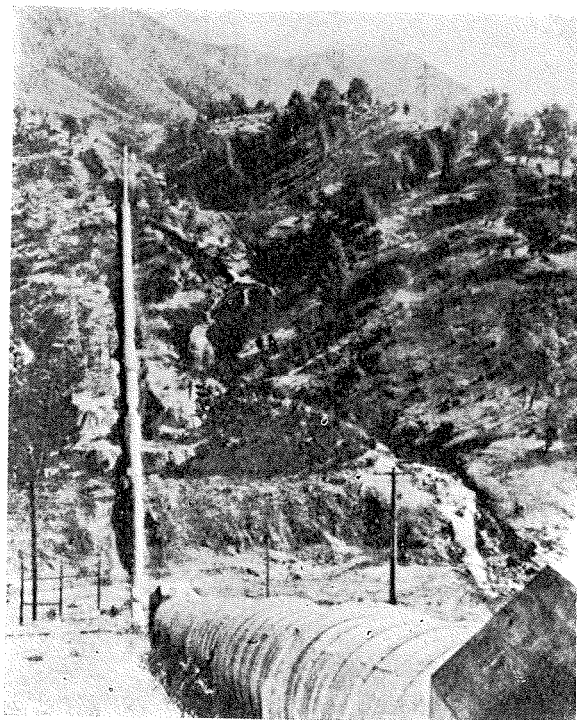
(12) レッドマウンテンパーのサイホントウルムネ河横断 溪谷の部分は9 \frac{1}{2} 呎の鐵管を厚い混凝土で防護してゐる。
