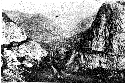
(2) オシヤウネシー堰堤築造前に於けるヘツチヘツチ大溪谷
