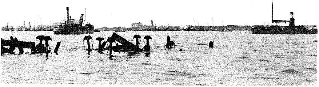
(16) 大棧橋の被害状況、写真(14)の裏面である。
