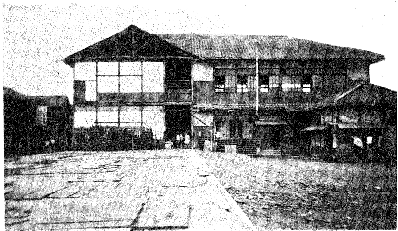
○ (17) 龜橋第二小學校の被害、左方倒壊した校舎は取片付けられた。
