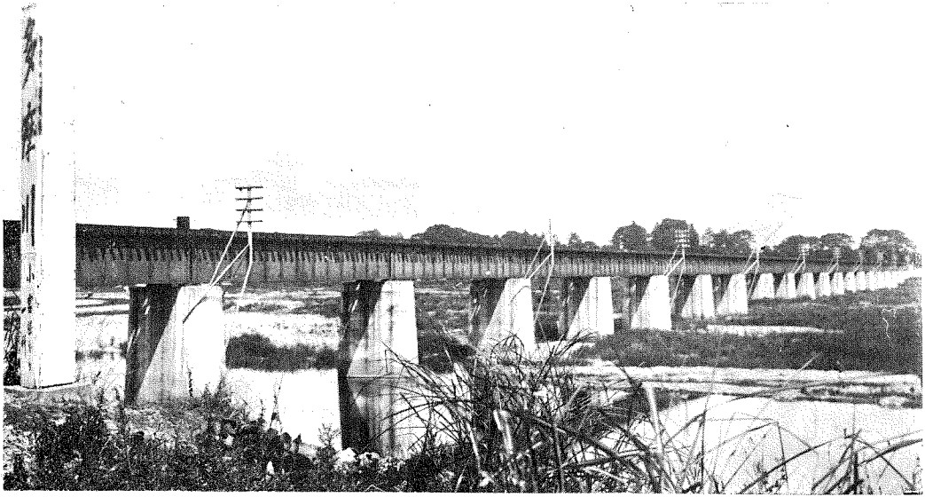
(1) 八高線多摩川橋梁
