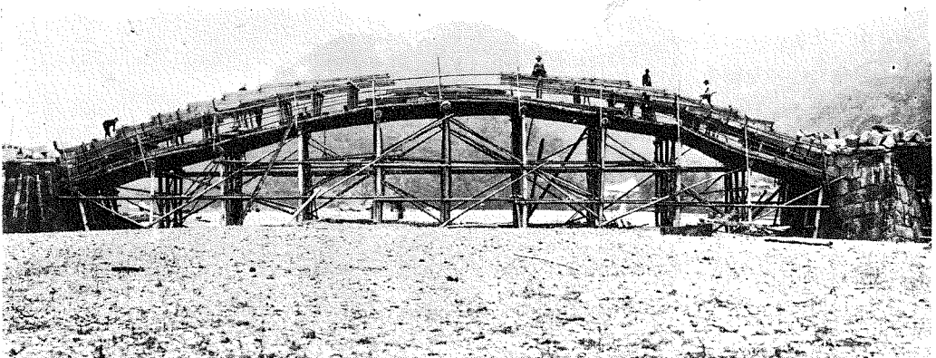
(7) 上流より見たる 拱橋組立工事實況。
