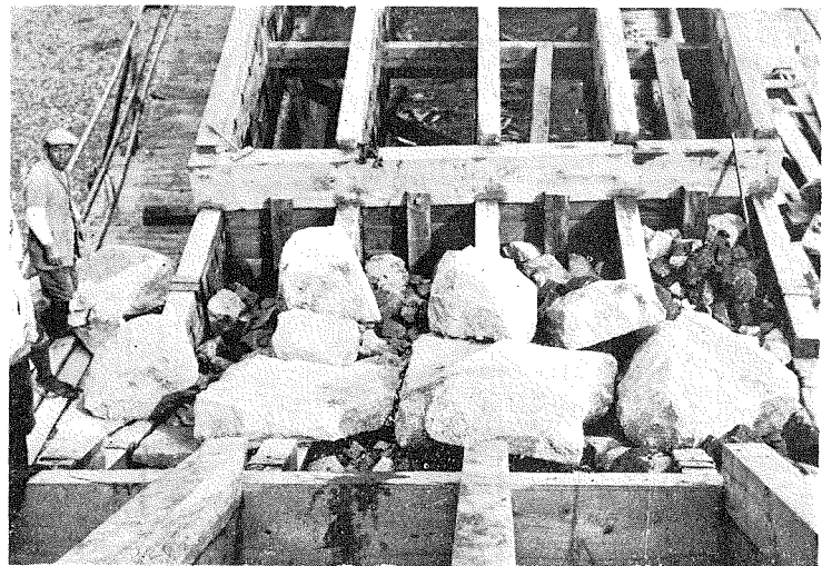
(6) 第三橋上より見たる第二號ピイア内部。
