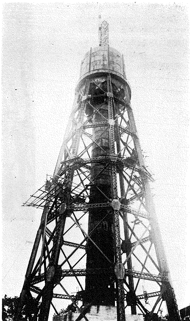
寫眞81 完成せる脚部とタンク底部。
