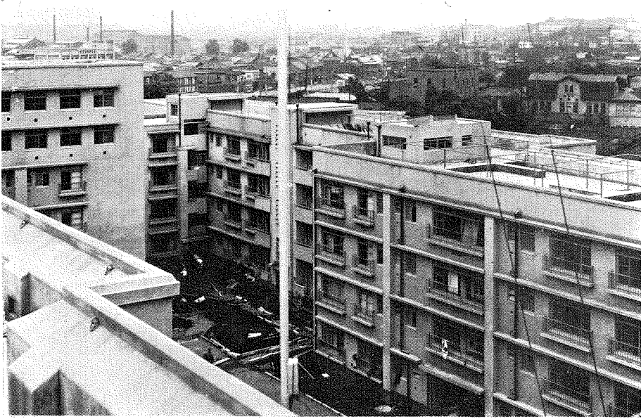
(4) 江戸川アパート・1 号館 屋上より 2 号館の一部を。
