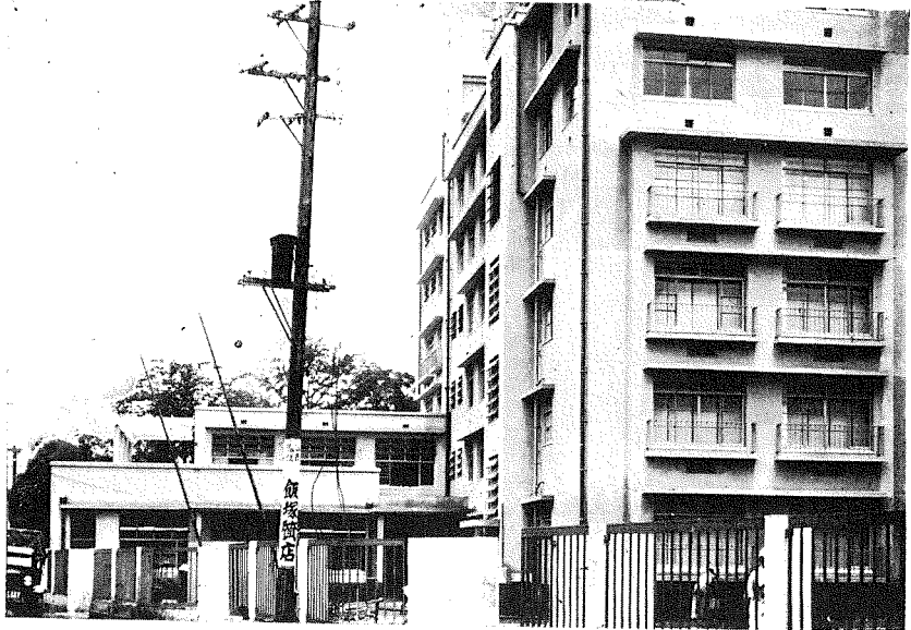
(3) 江戸川アパ ート・正門より1 号館の一部。
