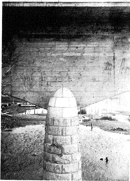
(14) 花水川橋 碇着徑間支點、主桁高3.5米、幅1.0米。
