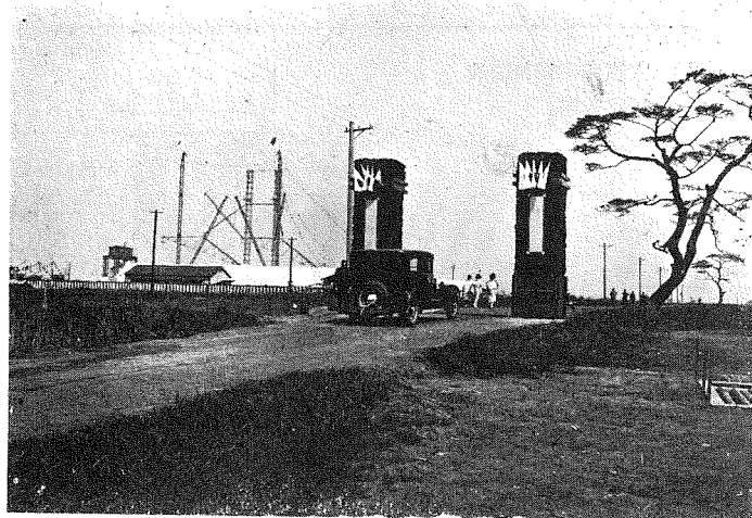
(I) 大阪北港修築起工式々場。
