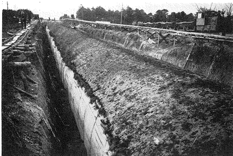
写真67 水壓混凝土管施工後土掩なし日光直射を防ぐ。
