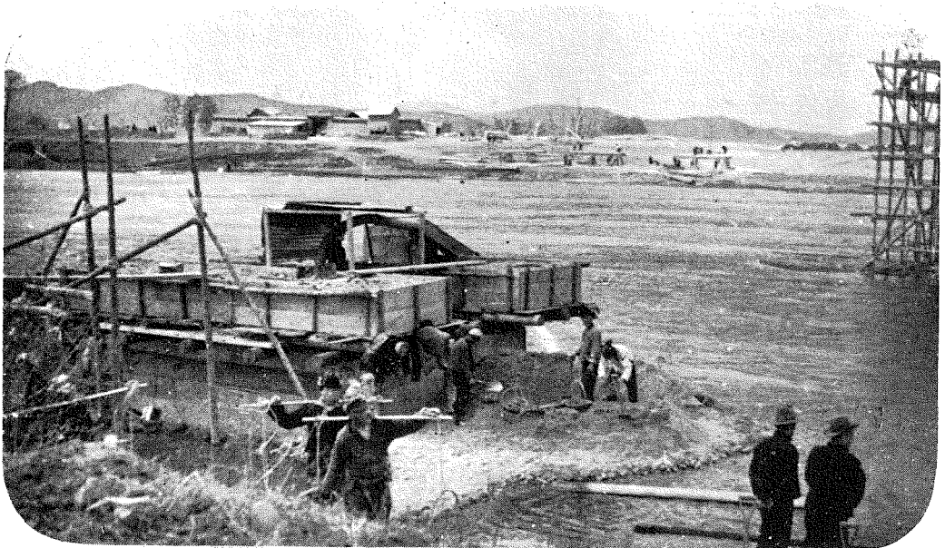
(5) 箱枠沈下作業・沈下荷重は土砂、築島は前同断である。
