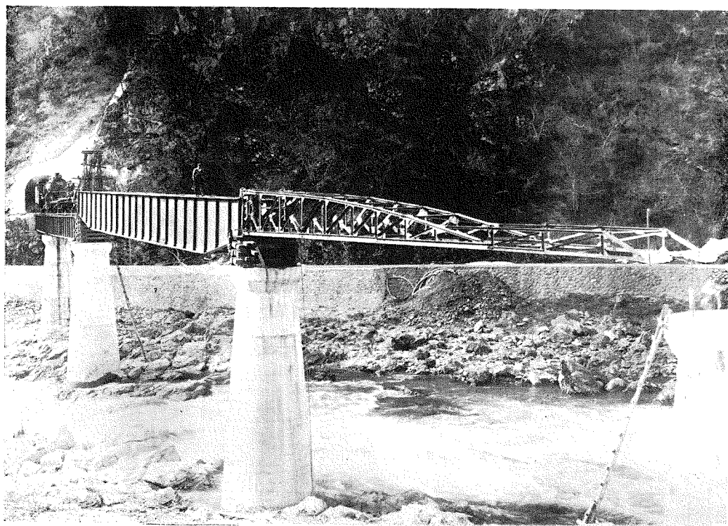
(4) 飛越線第十二宮川橋梁の手延式による架設工事状況その2。
