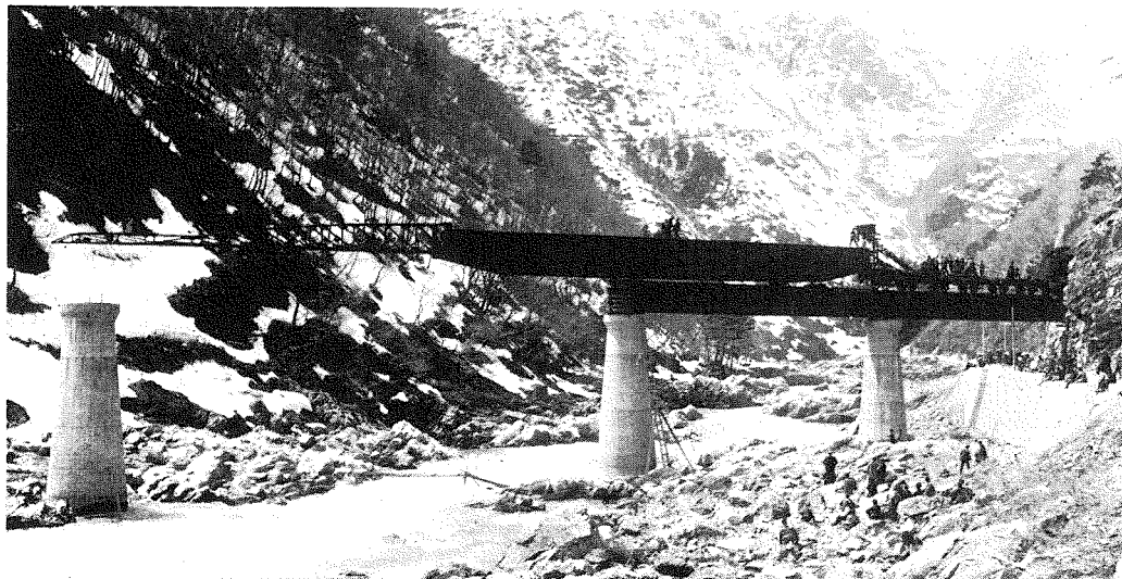
(3) 飛越線第十二宮川橋梁〈富山起點67杆085米〉支間34米50の手延式による架設工事。その1。
