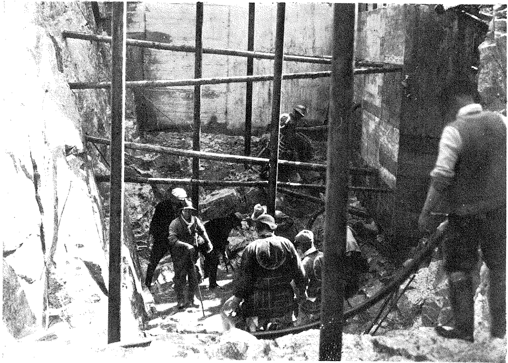
寫眞(13) 水洗せる堰堤中央 部カットオフ・9年4月
