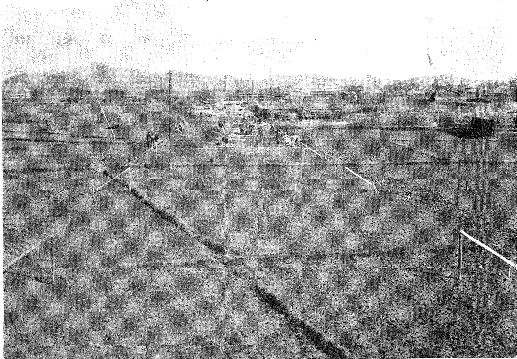
(2) 施工前の工事起点附近。
