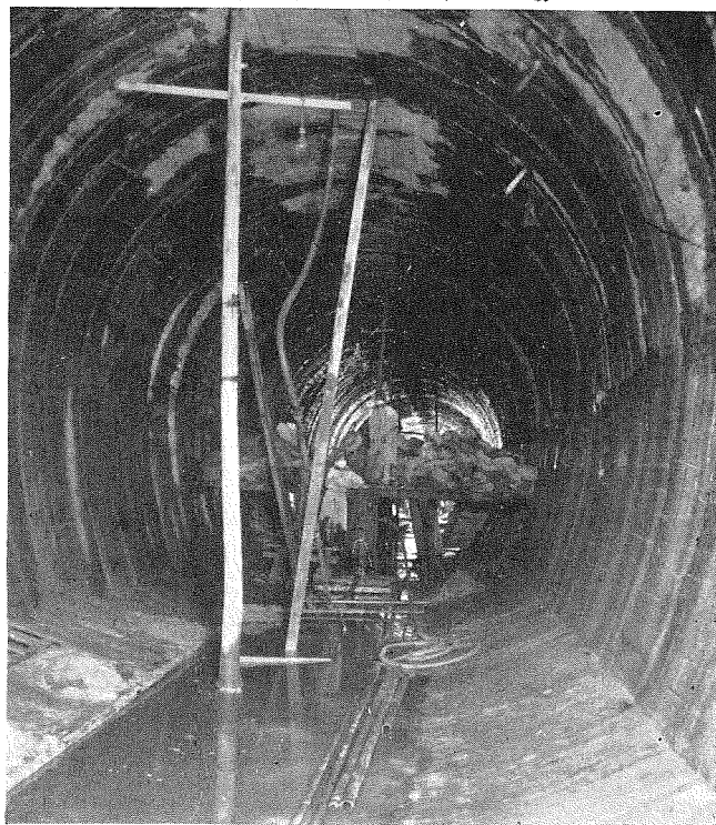
寫眞38 グラウチング
