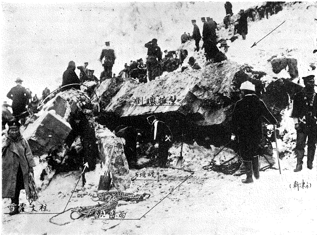
(13) 倒 壊 雪 壁 及 雪 覆 の 状 況。
