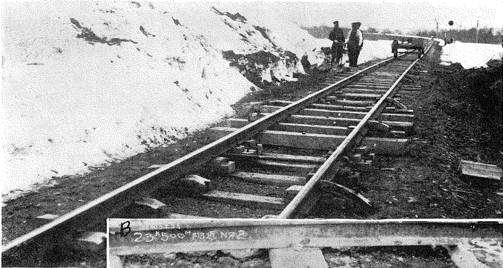
(1) 札幌鐵道局管内、釧網線細岡—塘路間に於ける挾木挿入箇所狀況
