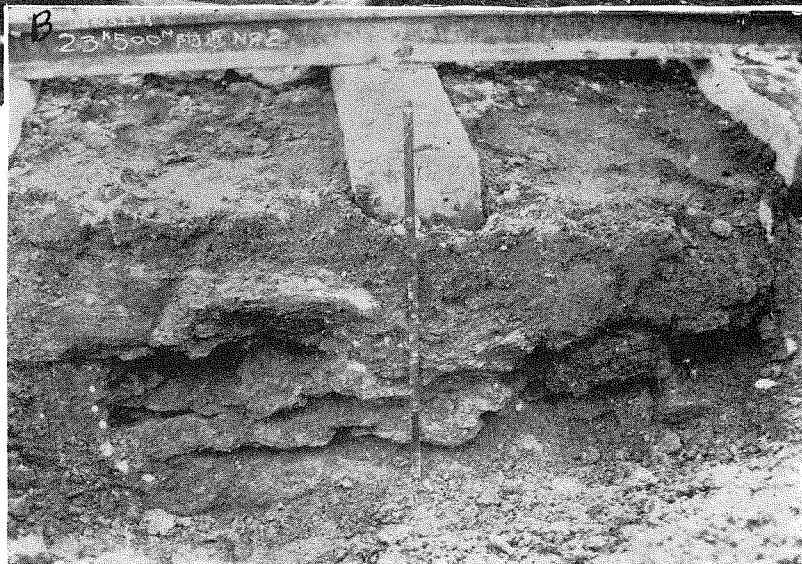
(1) 札幌鐵道局管内、釧網線細岡—塘路間に於ける挾木挿入箇所狀況
