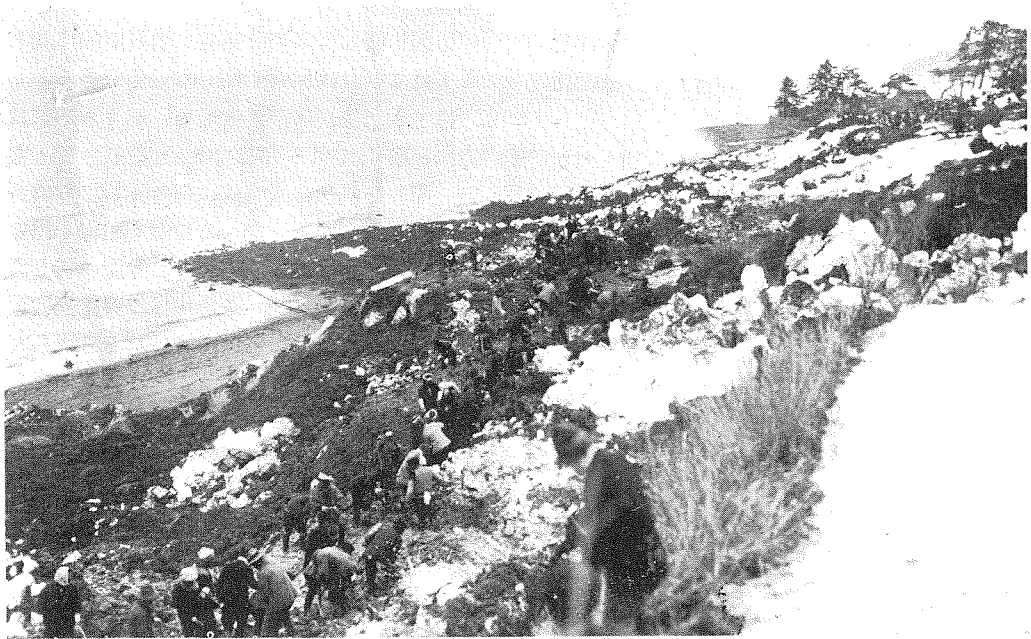
第2圖 崩壞土砂に埋れ或は海岸に押出されたる線路の復舊作業(昭和9年2月17日Am9~10米原方より撮影)
