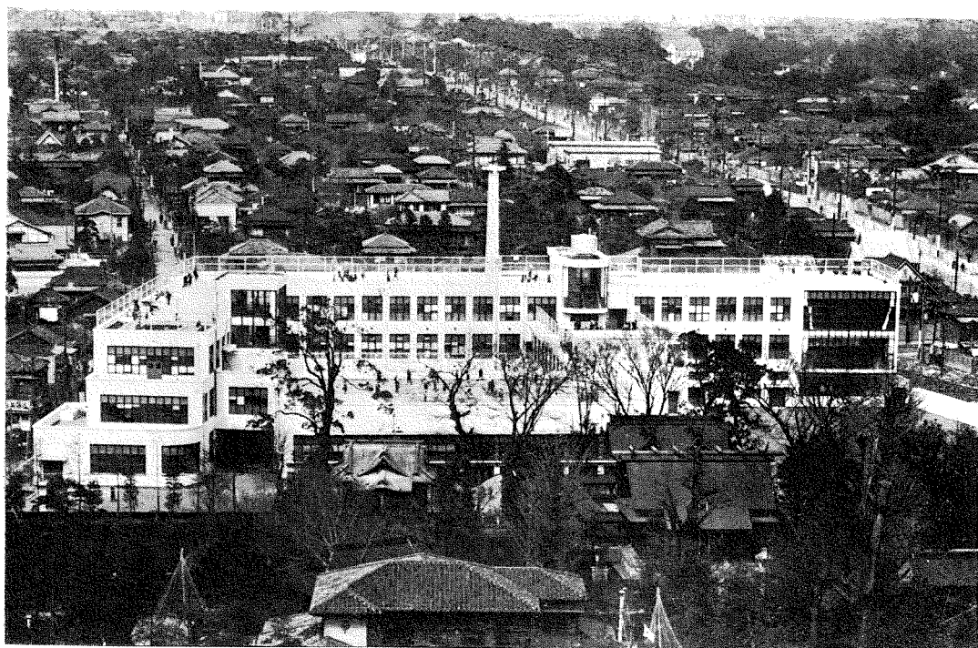
(f) 東京市四谷第五小學校全景 (西南より)
