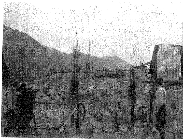
写真23 グラウチング工事
