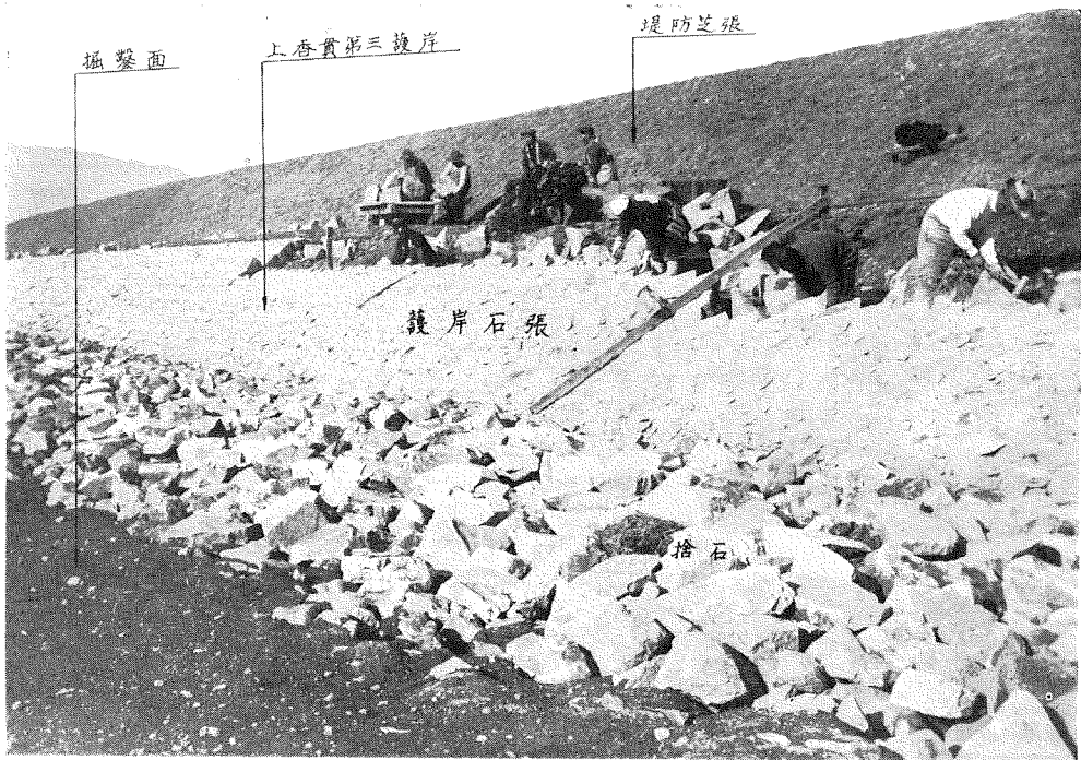
狩野川改修工事状況其七。
