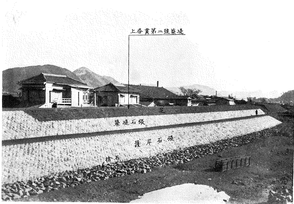
狩野川改修工事狀況其六。
