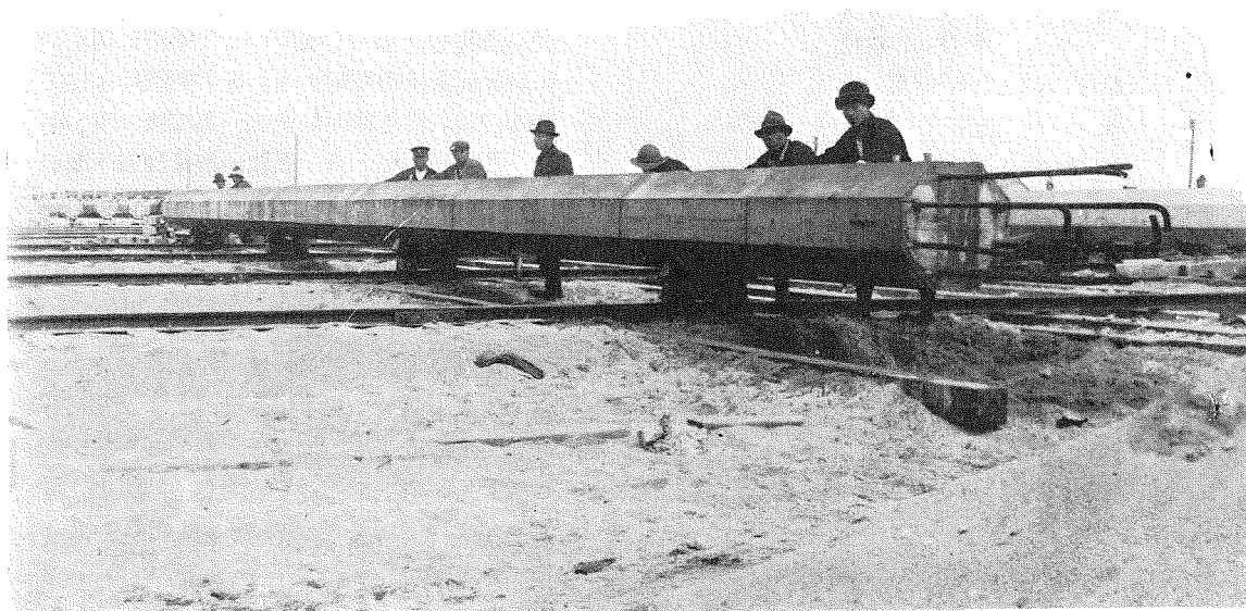
2. 杭製作工場に於ける混凝土杭移轉狀況。
