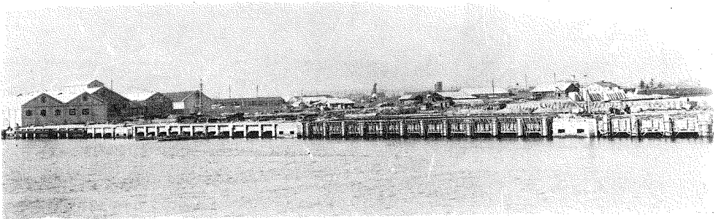
5. 工事中の埠頭横橋全景。
