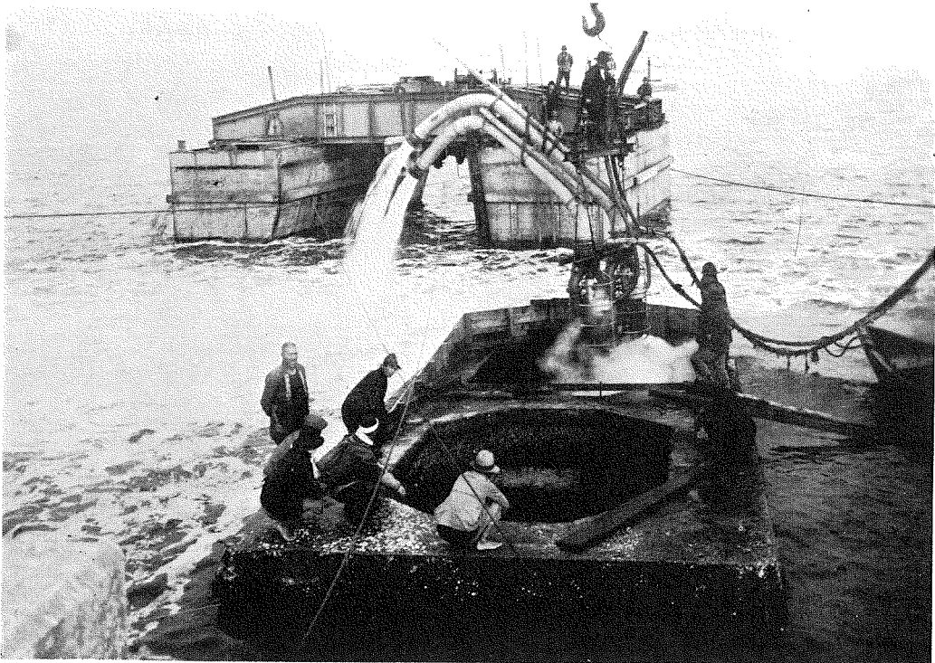
(20) 函内排水作業
