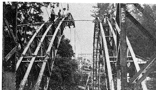
(8) 氷川大橋鋼構架設狀況。
