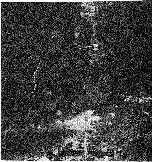
(13) 南水川橋々臺及橋脚工事。
