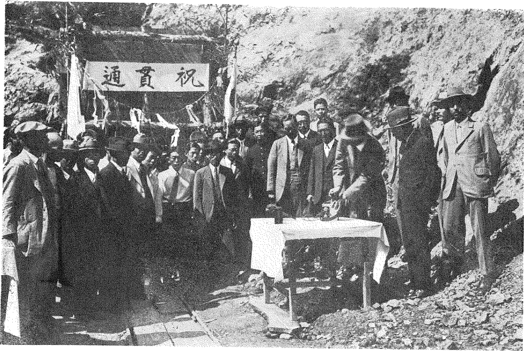
(4) 昭和八年九月二十六日導坑貫通式。坂本所長の手に依り電氣爆破を行ふ。
