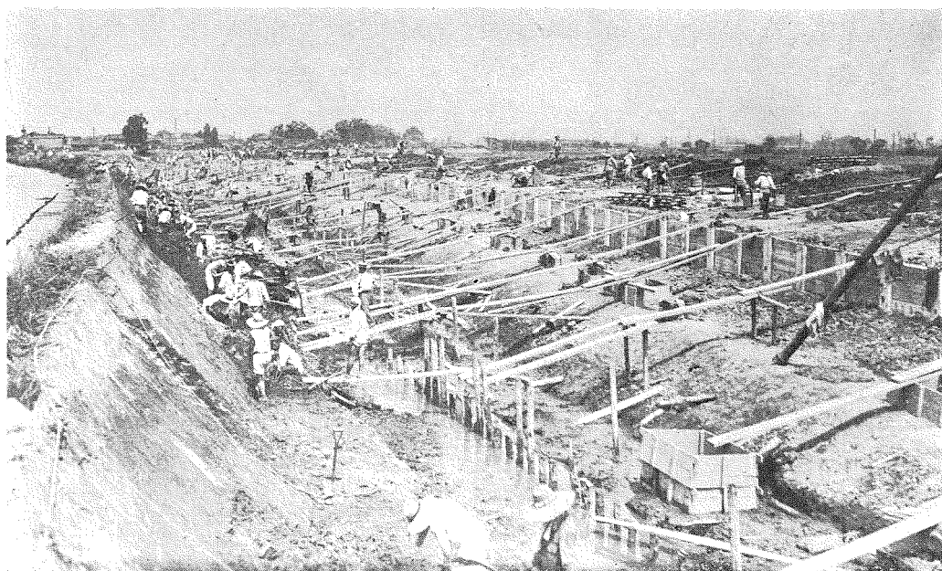
(2) 神崎川改修西島町地先、川敷擴張部分舊堤掘鑿新堤築造中の光景(右側新堤左側舊堤)
