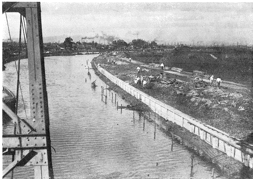
(3) 同上、西島町地先 川敷擴張箇所舊堤掘鑿を終り新堤及矢板式護岸工略完成の状況。
