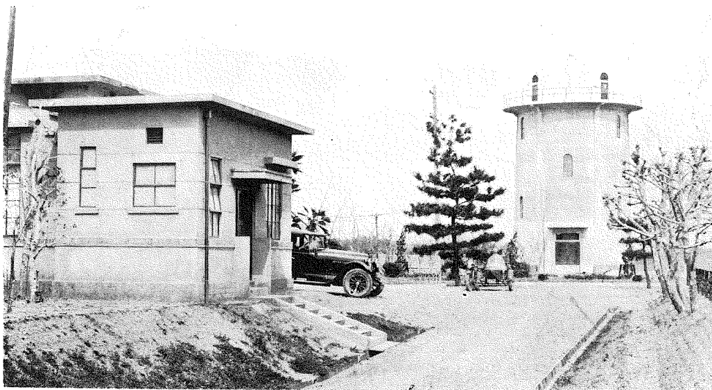
(8) 沈澱池構内調壓槽、徑10メートル6、高23メートル7。
