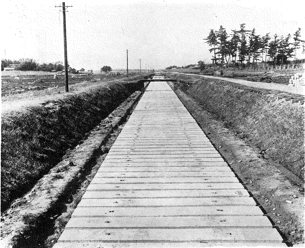
(5) 送水路開渠覆蓋工事(鷹來村地内)
